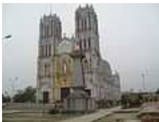
Thánh đường giáo xứ An Lập, còn có tên khác là nhà thờ Hải Lý ở Hải Hậu, Thái Bình trong tình trạng đổ nát xiêu vẹo. Sau bị đổ xập, nay không còn nữa.
